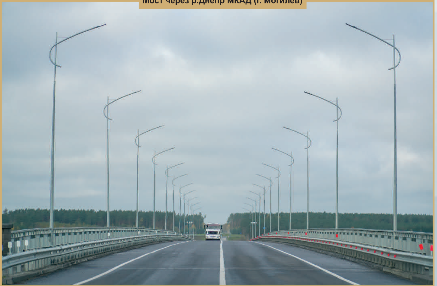
Мост через р.Днепр МКАД (г. Могилев)
